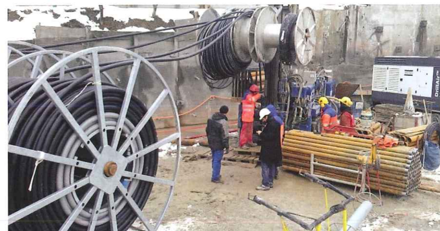
Les sondes géothermiques
